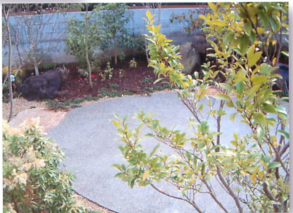
洗い出し（御浜）テラス
