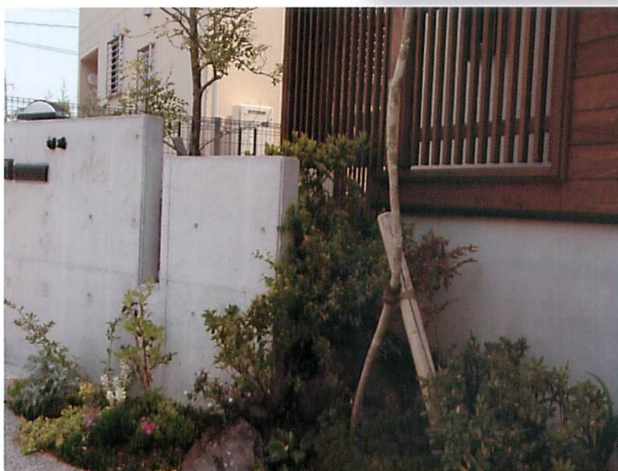
門柱と太閤石での土留め
